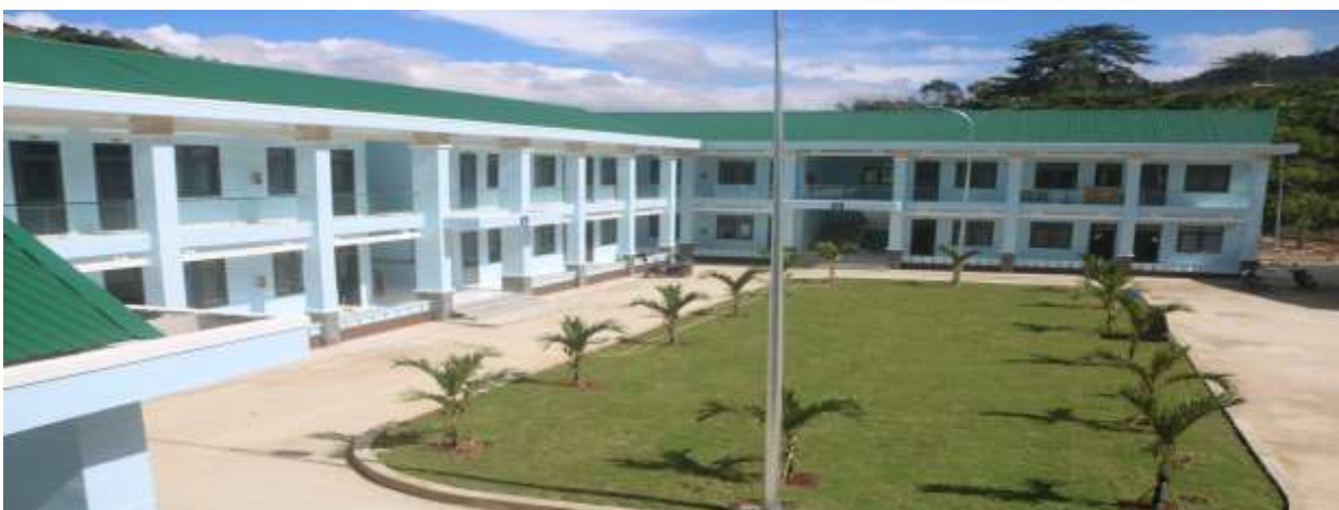
Nhà đi ca cho CBCNV Nhà máy Thủy điện Đồng Nai 5.
