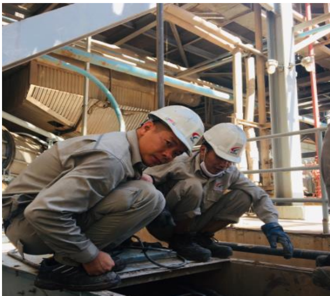
Công nhân sửa chữa đang xử lý sự cố
